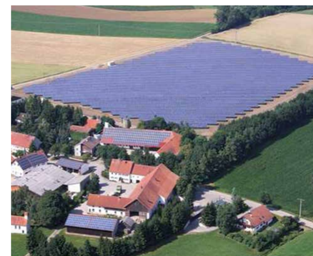
PV-Park Ammersee - 2,3 MW / Trina TSM-PC05 235 Watt Wechselrichter: SolarMax, Bauzeit: 8 Wochen
